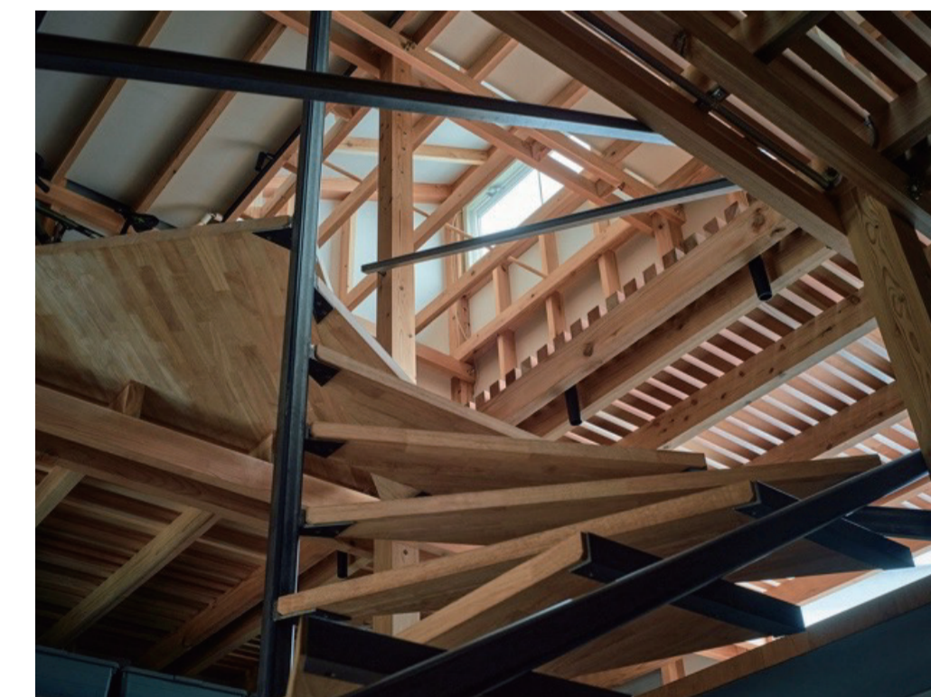
階段 柱にボルト固定した40角のスチールさらに段板を乗せて固定。容易に取り外し可能である。
