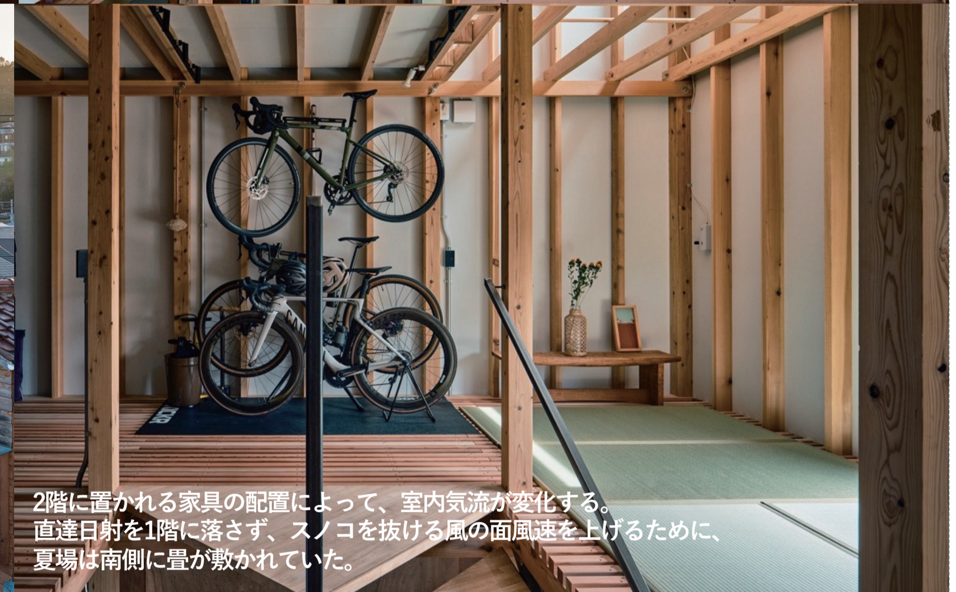
2階 床は全てスノコになっている。3つのハイサイドライトの光が明るさ感を生む。内装仕上げはなく、調湿性のある外装下地がそのまま現しとなっている。
