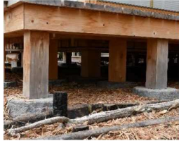
石場建て 柱と基礎を緊結しない =仕様規定に 不適合
