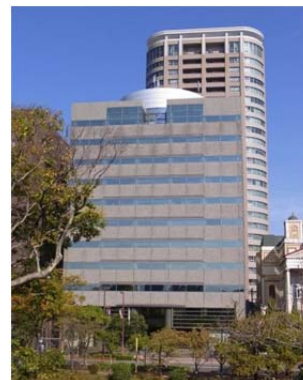
写真1 建物外観(南側)
